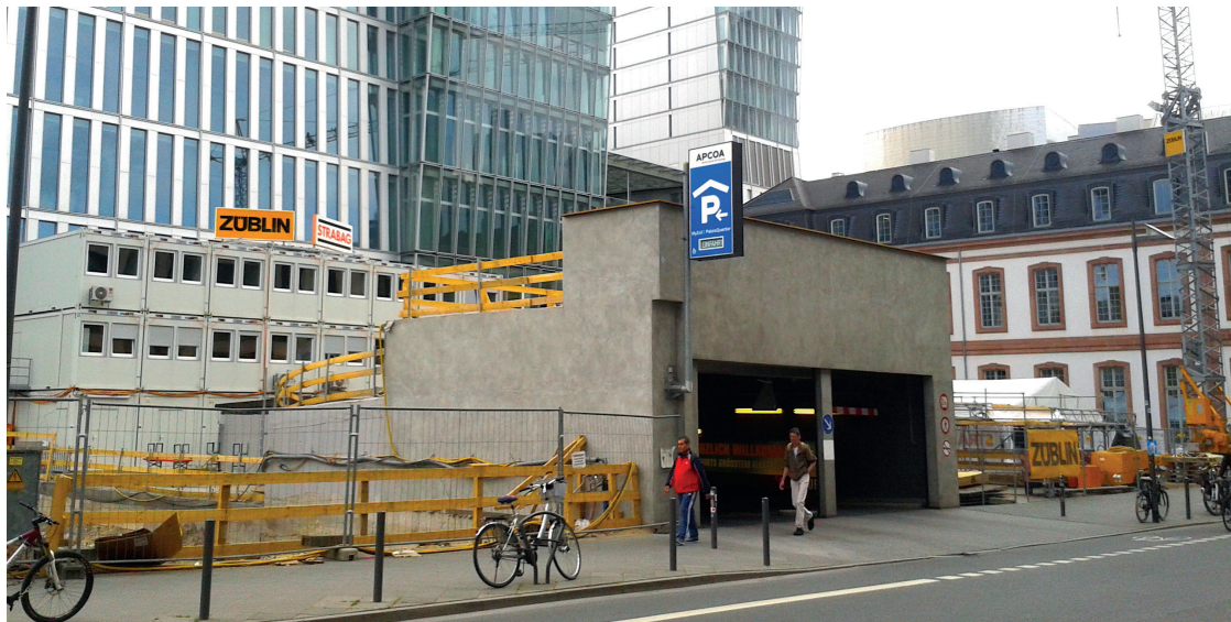
Auf dem Baugrundstück befindet sich die Tiefgaragen-Zufahrt für das PalaisQuartier. Quelle: Immobilien Zeitung, Urheber: Lars Wiederhold
